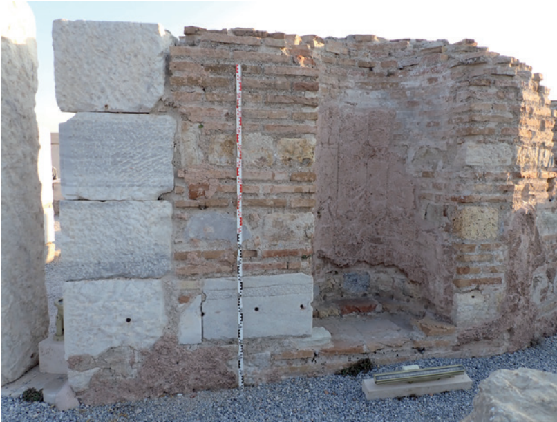
3 Ephesos, Baptisterium. Mauerwerk am südöstlichen Kuppelpfeiler mit kleiner Nische, Blick nach Norden aus dem Umgang | Ephesos, baptistery. Masonry on the south-eastern dome pillar with small niche, view to the north from the gallery (© ÖAW-ÖAI, G. Styhler-Aydın)
