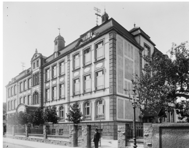
Stadtarchiv Mannheim für diese Dokumentation mit freundlicher Genehmigung überlassen
